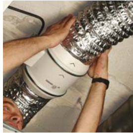
Raccorder les conduits.
