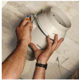
Insérer le corps moteur-hélice.
